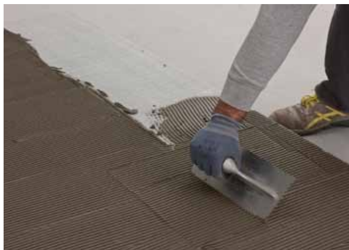
fig.36 / Stesura della colla sul retro della lastra. / Application of the adhesive on the slab back side.
