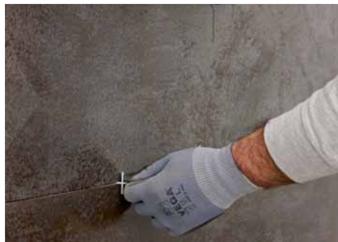
fig.37 / Fuga con distanziatori. / Application with spacers.
