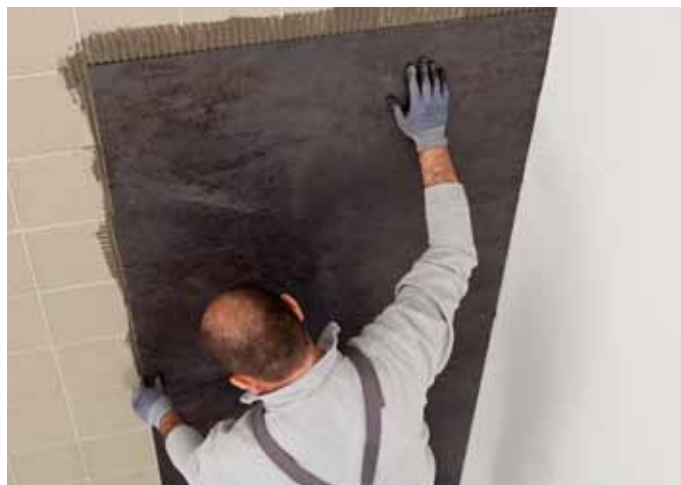
fig.38 / Posa della lastra. / Application of the slab.
